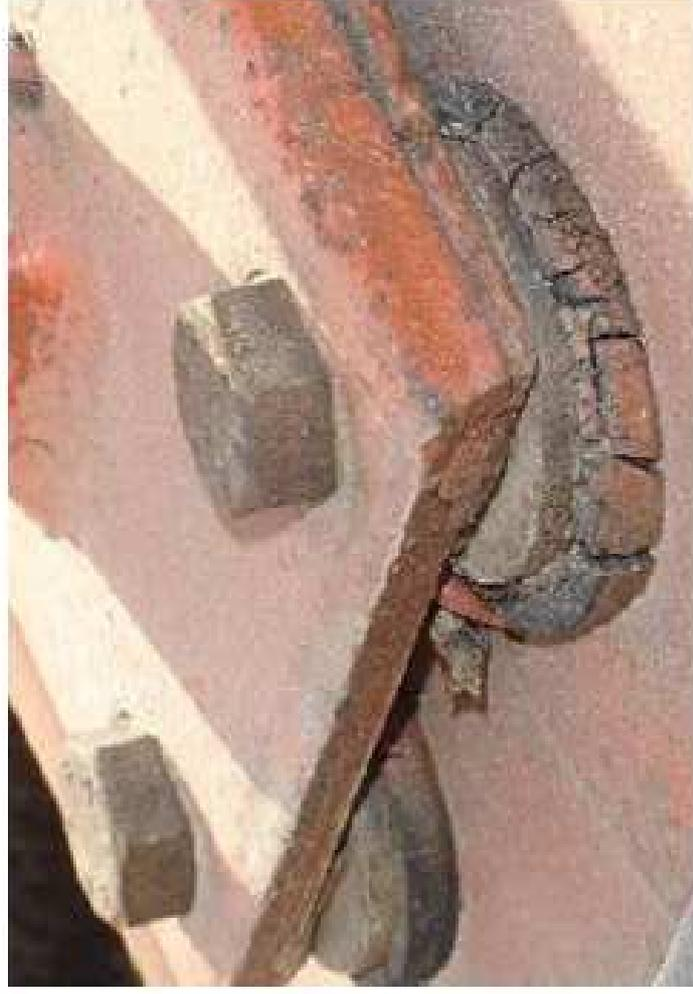
**Fig. 9. Un esempio di tassello in gomma compromesso nella sua funzione, a causa di un pronunciato degrado dovuto ad invecchiamento.**
