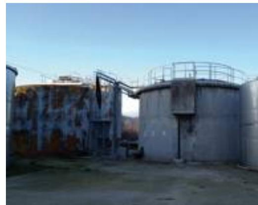
**1 - I due digestori che compongono la fase biologica dell'impianto biogas presente all'interno del Caseificio Sociale Ponte di Barbarano; a sinistra il digestore primario, a destra quello secondario.**
