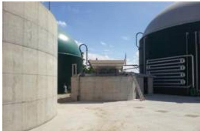
**5 - Impianto Dosso, da sinistra: vasca stoccaggio, digestore secondario con cupola gasometrica, vasca di preparazione coperta, digestore primario con scambiatore esterno.**
