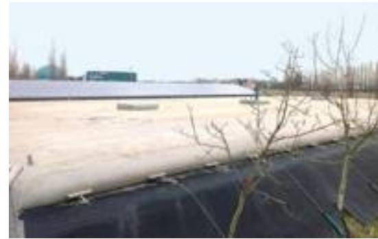
**6 - Lo stoccaggio a saccone da 5.000 m<sup>3</sup> con sullo sfondo una delle porcaie e l'impianto biogas.**
