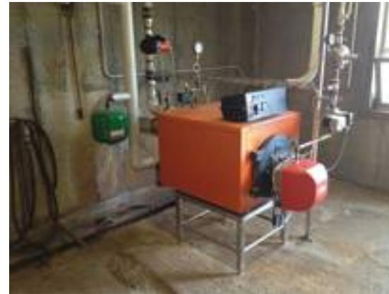
**2 - La caldaia con bruciatore a biogas installata di recente in sostituzione di quella originaria a funzionamento misto biogas-metano.**
