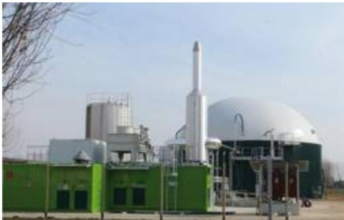
**4 - Alcune componenti l'impianto biogas: in primo piano il gruppo di cogenerazione, sullo sfondo, a sinistra, il serbatoio per l'accumulo del latticello e sulla destra il digestore primario.**
