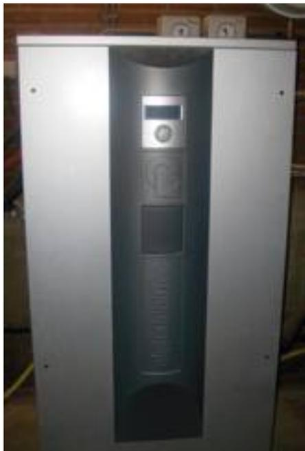
La pompa di calore scalda l'acqua partendo da acqua già in parte preriscaldata grazie al sistema tripla E.
