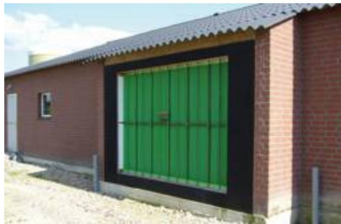
**Lo scambiatore di calore nel sistema GeoBalance riscalda l'aria in entrata d'inverno e la raffredda d'estate.**
