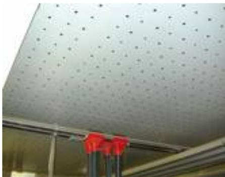
**Soffitto filtrante e diffusore installato in una porcilaia (fonte: Crpa).**
