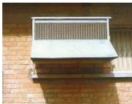
**Scambiatore di calore a fluido bifase installato in una porcilaia (fonte: Crpa).**
