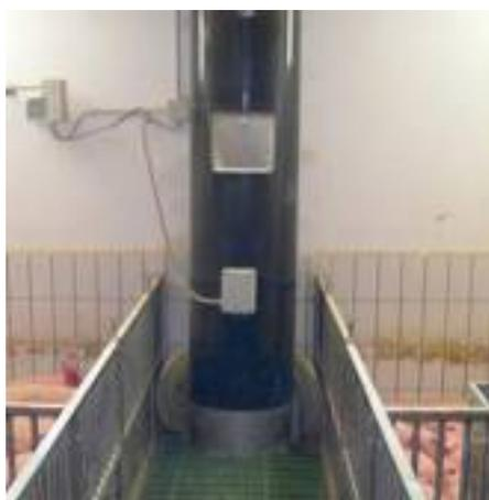
**Impianto di ventilazione in depressione con camino in una porcilaia (fonte: Crpa).**
