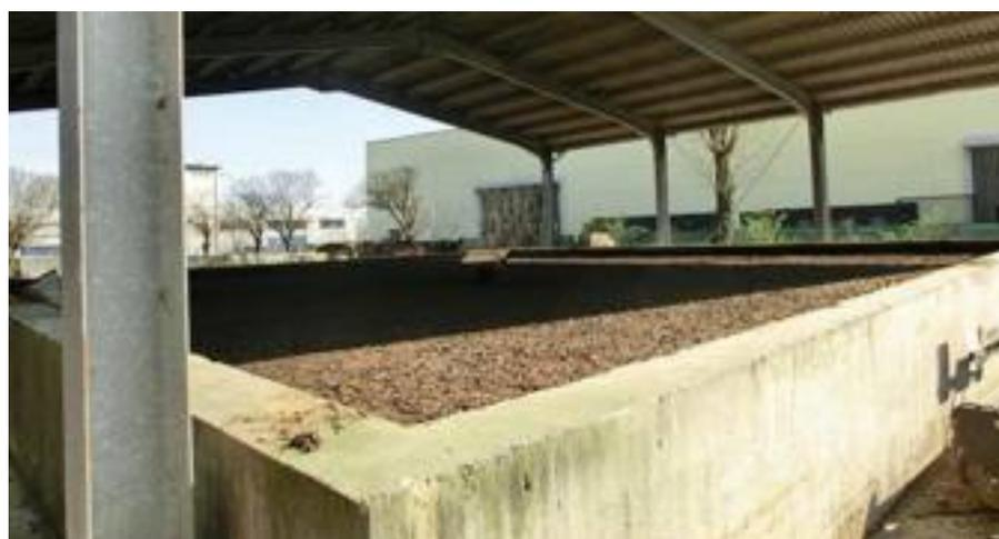
● Figura 4 – Vasca di stoccaggio per liquami coperta da una struttura intelaiata in acciaio zincato.
