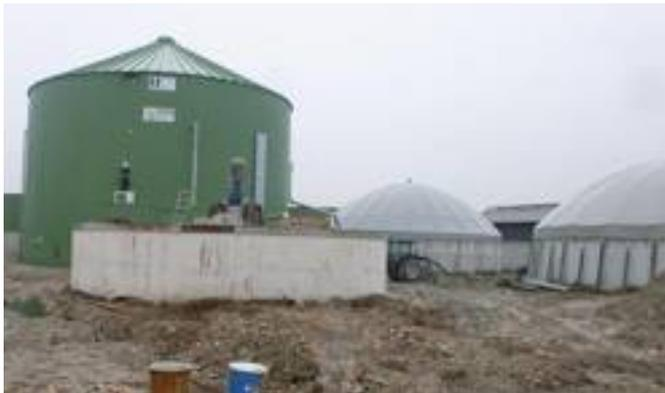
● Figura 10 – Un digestore anaerobico alimentato con deiezioni bovine; in evidenza le vasche di stoccaggio coperte.
