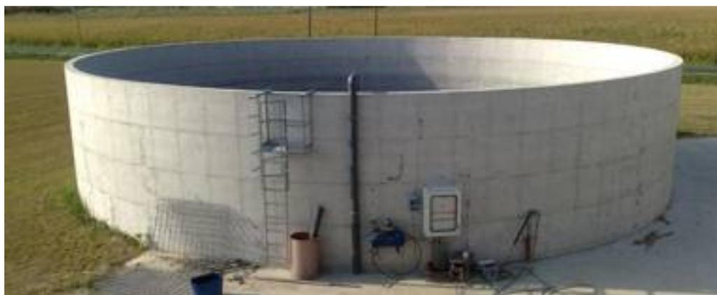
● Figura 2 - Vasca prefabbricata in cemento armato a pianta circolare, a cielo aperto.
