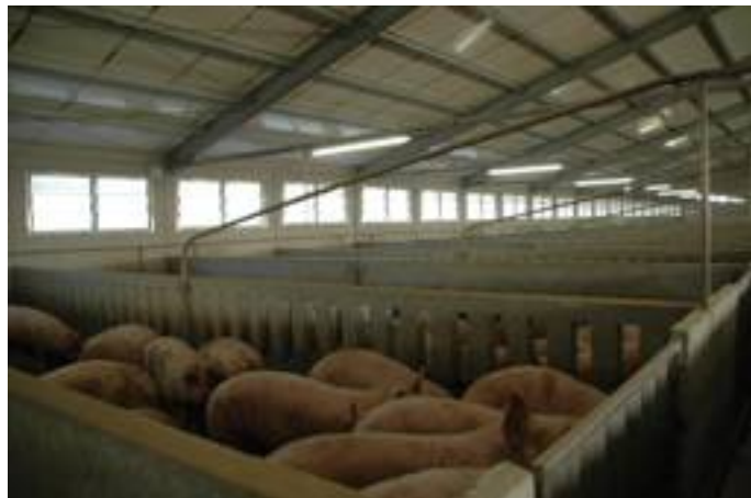
La struttura realizzata dall'azienda Bonvicini è dotata di volte alte e ventilazione naturale, assicurata da finestre automatizzate a controllo elettronico.
