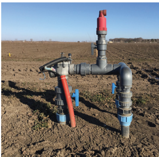
Figura 19 - Dettagli del sistema di fertirrigazione (a sinistra: valvole di controllo; a destra: linee di gocciolamento).
