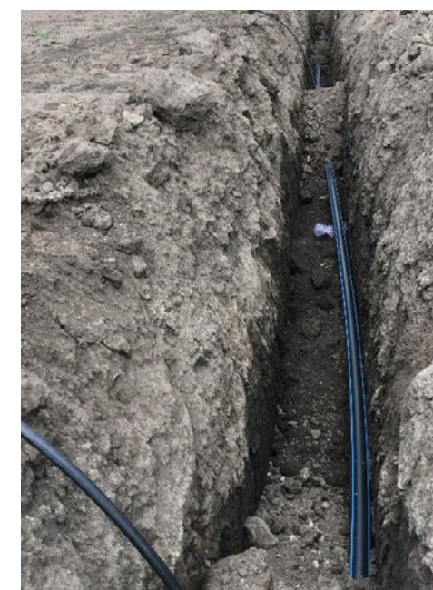
Figura 13 - Posizionamento del collettore in HDPE e ala gocciolante interrata.
