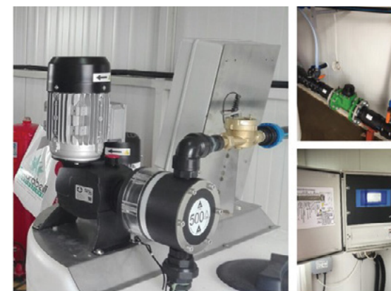
Figura 46 - Iniezione di fertilizzante calibrata da una pompa dosatrice sotto il comando dell'unità di controllo della fertirrigazione.
