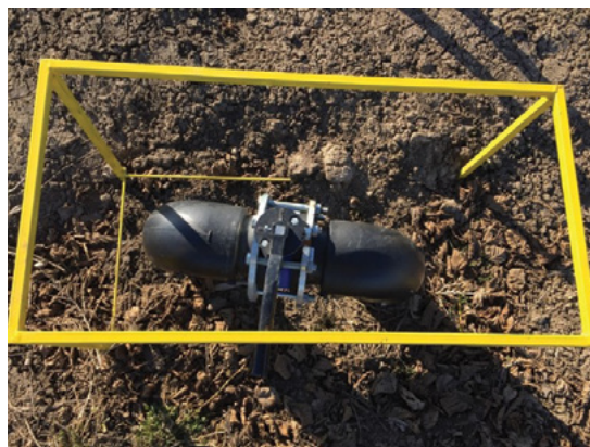
Figura 40 - Valvola a farfalla azionata manualmente su una linea principale.
