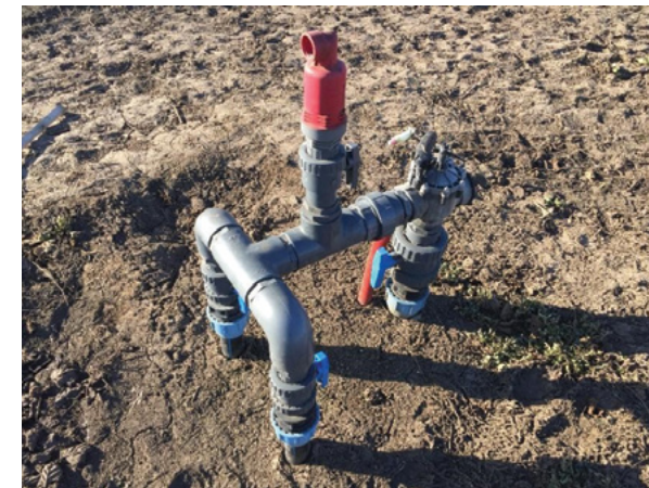
Figura 42 - Valvola di sfiato (rossa) regolata da una valvola a sfera (leva grigio scuro) posizionata a valle della valvola di controllo (a destra) di un blocco di irrigazione (settore). Altre valvole a sfera in PVC (leve blu) nell'impianto consentono diverse opzioni, quali operazioni di riparazione e manutenzione, nonché la divisione del settore in due parti.
