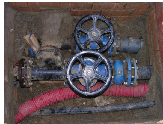
Figura 41 - Valvole a saracinesca all'ingresso del sistema.
