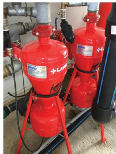
Figura 26 - Separatore di sabbia. Nella parte inferiore, il contenitore di raccolta con valvola di scarico rapido.
