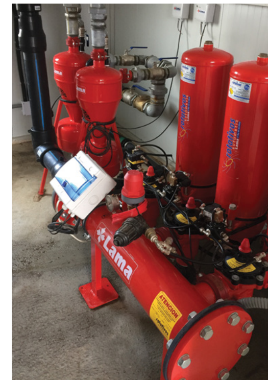
Figura 27 - Banco di filtrazione composto da separatori di sabbia e filtri a disco per il trattamento dell'acqua proveniente da pozzi trivellati.
