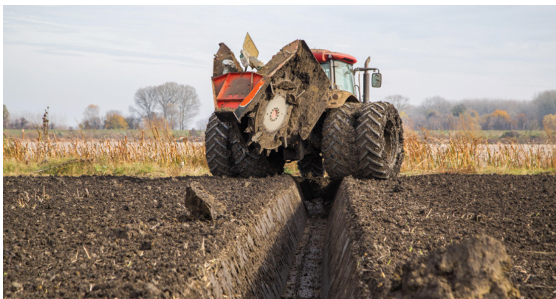
Apertura di canali di drenaggio
