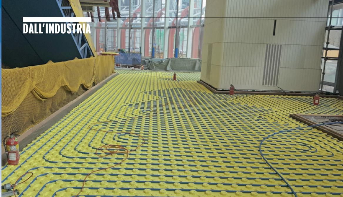
L'incremento delle prestazioni offerto dal pavimento radiante (+5÷10% dell'efficienza complessiva) ha permesso la riduzione dei volumi richiesti all'impianto ad aria primaria per la climatizzazione (RDZ - Eco Enerdigm RDZ-SEM Corporation).
