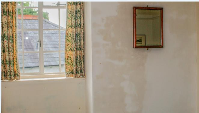
**Umidità igroscopica** – In questo caso la causa non è l'umidità di risalita ma l'accumulo di sali igroscopici nella bocca di un camino in seguito alla combustione di carbone.
