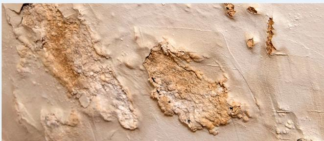
**Contaminazione da sali igroscopici** – L'intonaco pesantemente contaminato dal sale deve essere sempre sostituito, indipendentemente dal sistema barriera antiumidità utilizzato. La sola sostituzione dell'intonaco non risolve il problema, in quanto l'umidità risalirà anche oltre il livello del nuovo intonaco
