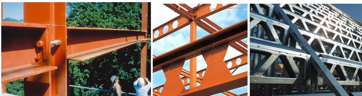
*Esempio di prodotti ricadenti nella EN 1090-1: travi composte saldate, travi alveolari e profili sottili formati a freddo*
