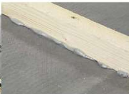
Fissare il controlistello con viti o chiodi.
