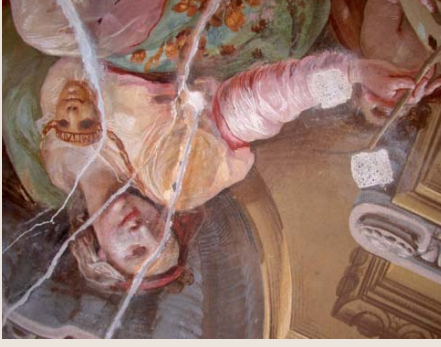
La causa principale del degrado delle decorazioni del teatrino era l'infiltrazione d'acqua protratta negli anni. Con il risanamento del tetto e degli intonaci esterni della facciata (negli anni '80 del '900) e il recente rifacimento del corridoio posteriore la situazione è stata normalizzata. Si è così potuto procedere con l'intervento qui descritto sulla superficie dipinta.
