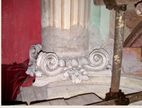
Il conicione in stucco con decorazioni a tempera, presentava efflorescenza saline provocate da vecchie infiltrazioni d'acqua; questo ha provocato la perdita di quasi il 50% della pellicola pittorica. Su tutta la superficie erano evidenti riprese pittoriche a temperone. Le pareti, rispetto al soffitto, si presentavano in peggiori condizioni conservative soprattutto a livello della policromia.
