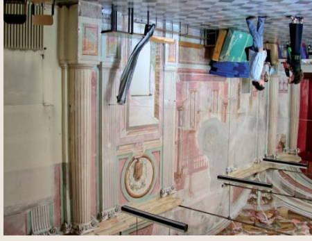
Il conicione in stucco con decorazioni a tempera, presentava efflorescenza saline provocate da vecchie infiltrazioni d'acqua; questo ha provocato la perdita di quasi il 50% della pellicola pittorica. Su tutta la superficie erano evidenti riprese pittoriche a temperone. Le pareti, rispetto al soffitto, si presentavano in peggiori condizioni conservative soprattutto a livello della policromia.
