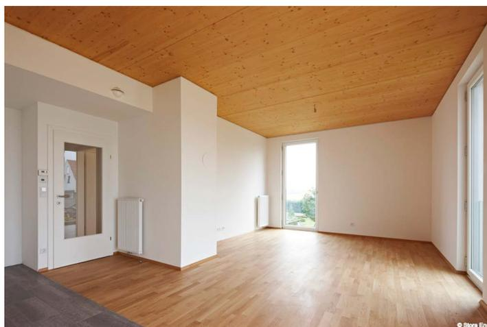
*I pannelli in CLT devono essere protetti in esterno, nella generalità dei casi, con rivestimenti diversi (dall'intonaco, a materiali differenti o con facciate a loro volta in legno). Lo stesso nel caso degli interni in cui siamo certamente abituati ad immaginare (e a "desiderare") un pavimento in legno ma non un soffitto (se non in contesti molto tradizionali).*
