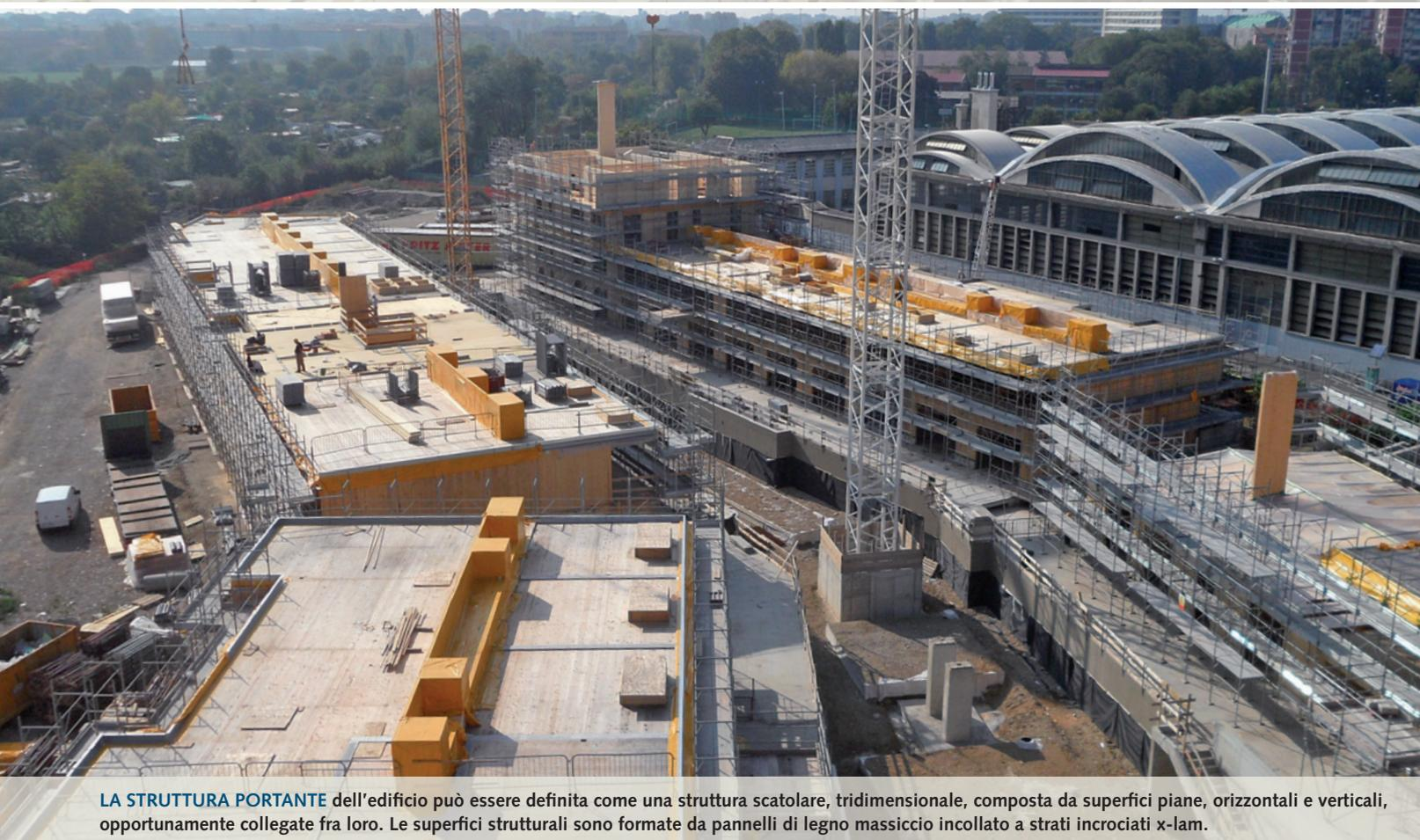
**LA STRUTTURA PORTANTE** dell'edificio può essere definita come una struttura scatolare, tridimensionale, composta da superfici piane, orizzontali e verticali, opportunamente collegate fra loro. Le superfici strutturali sono formate da pannelli di legno massiccio incollato a strati incrociati x-lam.
