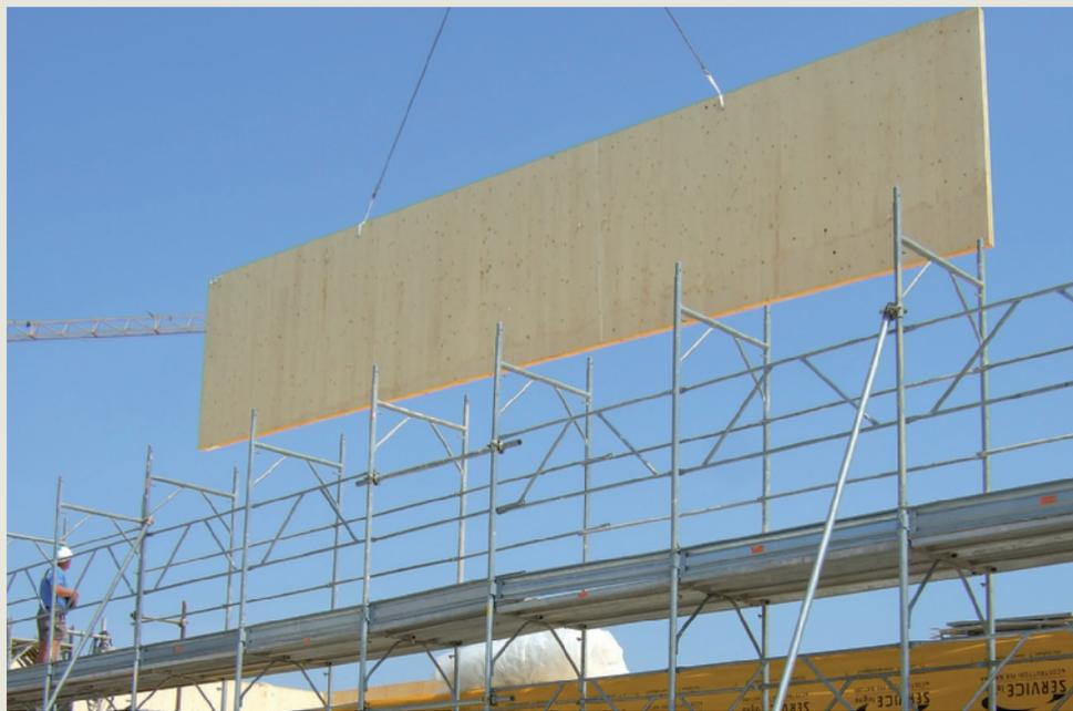
**IL SISTEMA COSTRUTTIVO** e strutturale delle stecche è formato da pannelli a strati incrociati x-lam.
