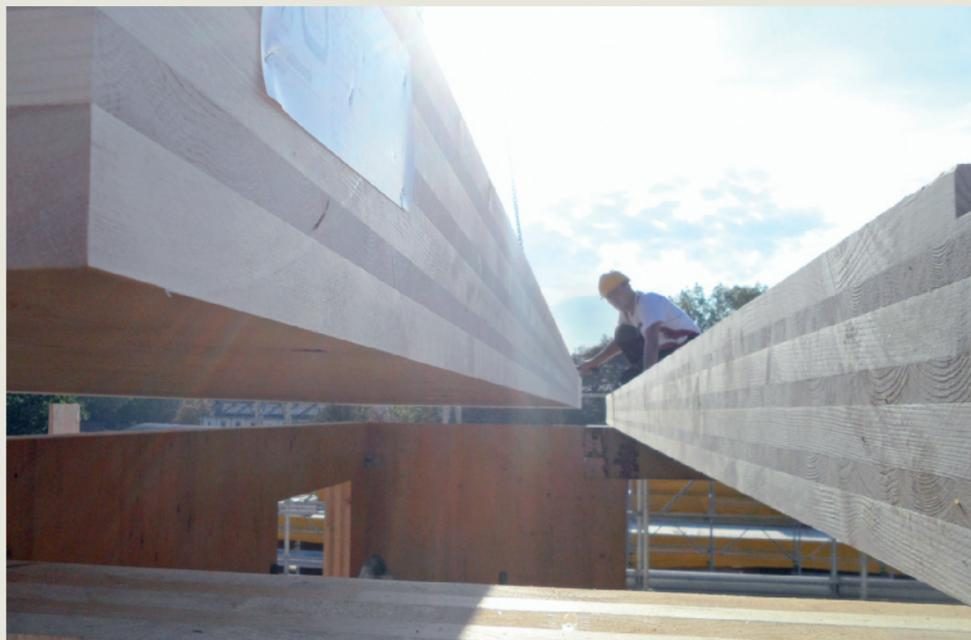
**LA STRUTTURA TRIDIMENSIONALE** è ottenuta dai collegamenti fra i pannelli X-lam che la compongono.
