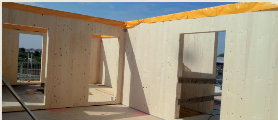
**IN CIASCUN PIANO** le pareti sono realizzate con pannelli x-lam dello stesso spessore e con la stessa stratigrafia.
