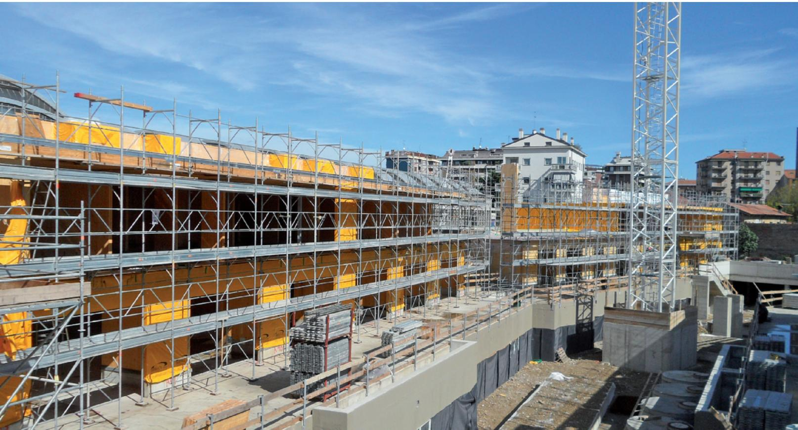
**IL SISTEMA COSTRUTTIVO** è a pannelli portanti in legno a strati incrociati. Le uniche parti realizzate in cemento armato sono il solaio del piano terra, le strutture in elevazione del piano interrato e quelle di fondazione, dimensionate sulla base dei carichi ceduti al piano terra dalle sovrastanti strutture in legno.
