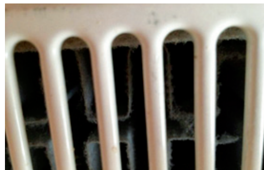
Figura 4.12: Stato di pulizia dei radiatori
