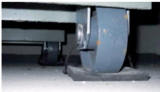
Figura 4.13: Posizionamento gomma anti-vibrazioni
