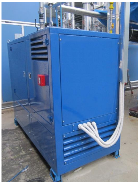
Impianto 40kWe Gas Naturale R.S.A. (MI)
