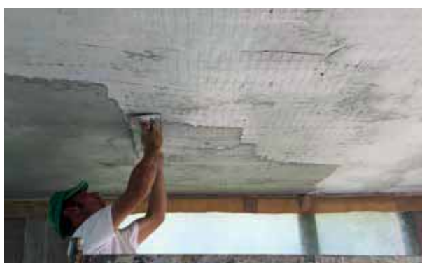
(6) Stesa della seconda mano della malta Plasterwall
