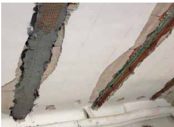
Esempio di solaio con ferri esposti e passivati, travetto con rinforzo FRCM con PBO-Mesh GOLD 105 e matrice inorganica PBO-MX Gold Calcestruzzo.
