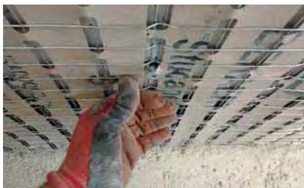
(4) Posizionamento del tassello meccanico per il fissaggio del pannello Stucanet® S
