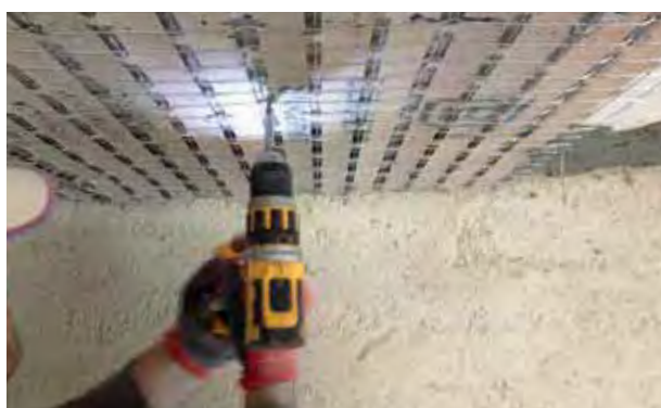
(5) Avvitamento del tassello meccanico per il fissaggio del pannello Stucanet® S
