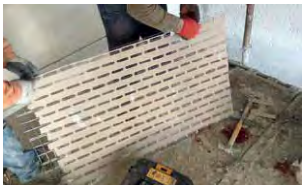
(1) Eventuale taglio a misura e preparazione del pannello Stucanet® S
