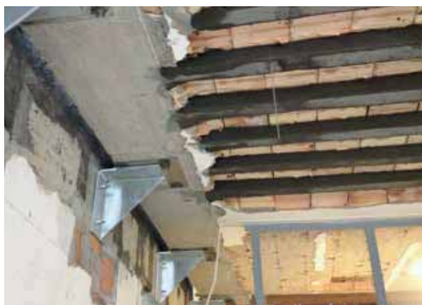
Esempio di solaio con fondello rimosso e ricostruzione volumetrica del travetto con malta MX Gold R4
