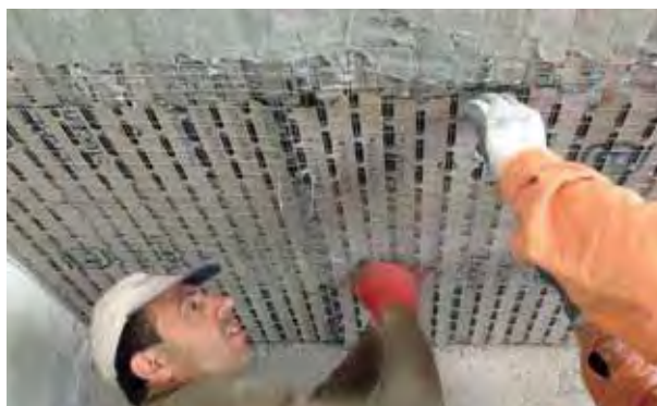
(2) Posizionamento del pannello Stucanet® S
