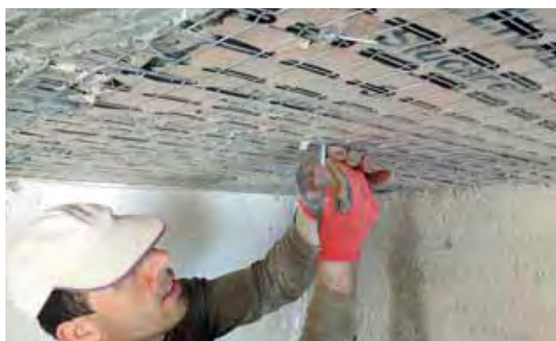
(3) Tracciamento ed esecuzione del foro per il fissaggio, con tassello meccanico, del pannello Stucanet® S
