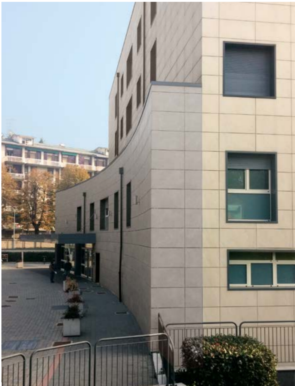
60x120 cm PARETE VENTILATA SISTEMA DI AGGANCIO A VISTA 60x120 cm VENTILATED FACADE VISIBLE ANCHOR SYSTEM
