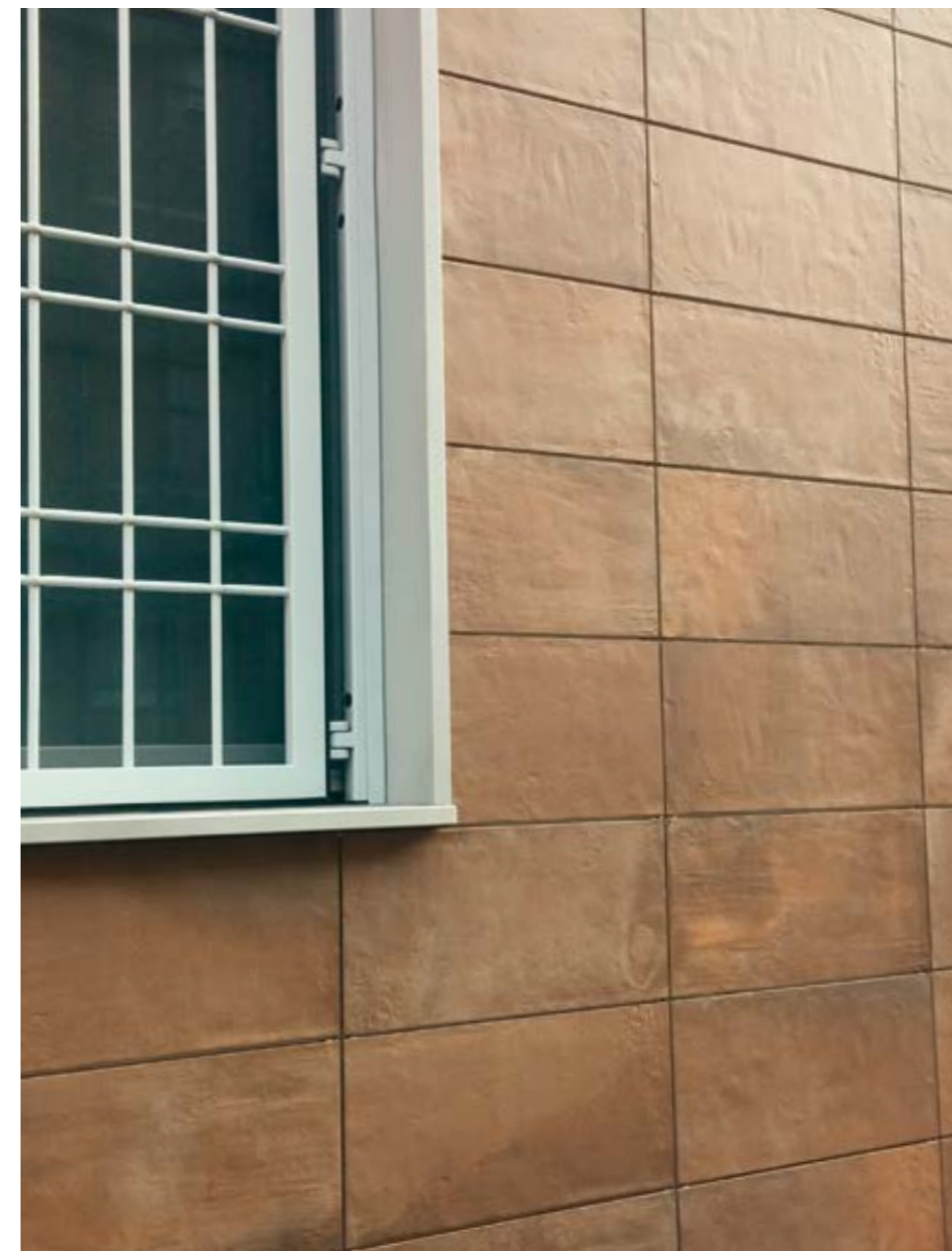
30x60 cm 30x60 cm FACCIATA ISOLATA VENTILATA VENTILATED INSULATED FACADE SISTEMA DI AGGANCIO A SCOMPARSA HIDDEN ANCHOR SYSTEM
