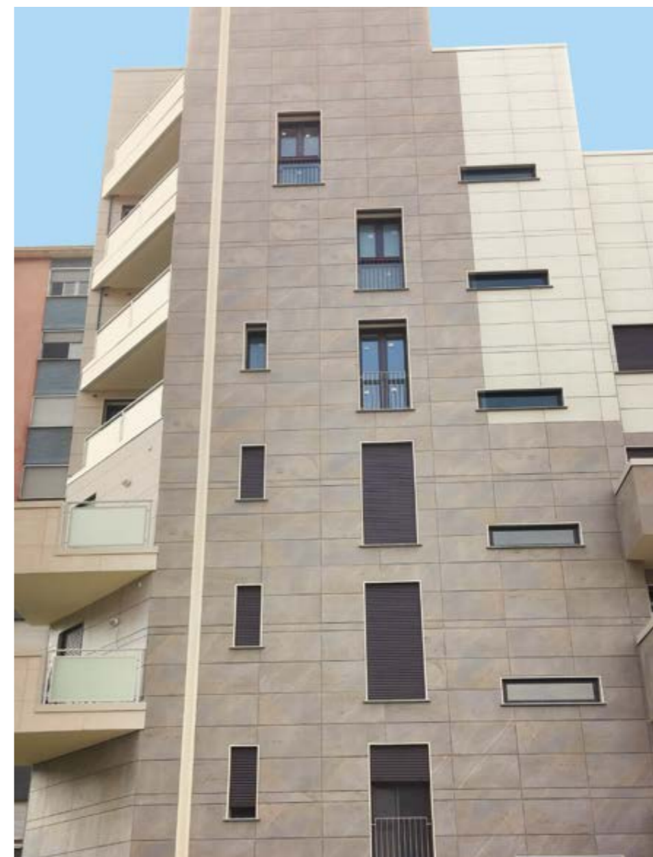
60x120 cm FACCIATA ISOLATA VENTILATA SISTEMA DI AGGANCIO A VISTA 60x120 cm VENTILATED INSULATED FACADE VISIBLE ANCHOR SYSTEM
