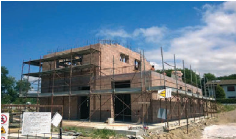
Piano primo: getto in calcestruzzo, classe di resistenza C25/30, fluidità S5 e inizio realizzazione cordolo di piano.
