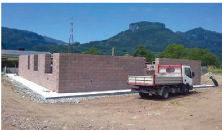
Piano terra: struttura in elevazione.
