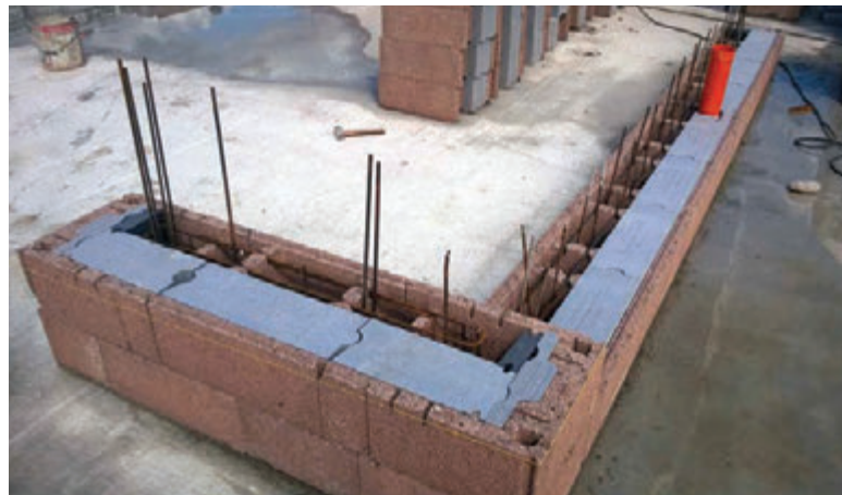
Montaggio del blocco ad angolo.
