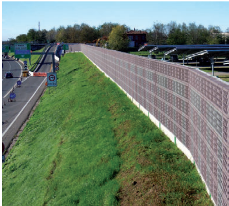
Barriera Fonoassorbente lungo la Tangenziale di Pavia.
