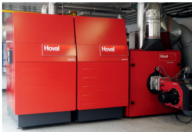
Cascata monovalente costituita da 2 UltraGas® e da una CompactGas per la copertura dei picchi di carico.
