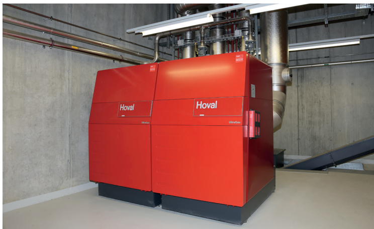
Centrale di riscaldamento per una rete di teleriscaldamento a corto raggio: 1 caldaia doppia UltraGas (1300D) fornisce elevata efficienza e affidabilità.
