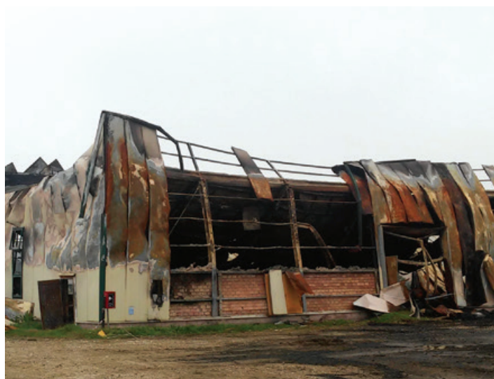
Stabilimento industriale con rivestimento metallico completamente distrutto in seguito ad un incendio.
