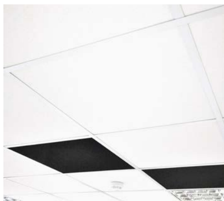
1 - Controsoffitto con struttura a quadrotti 60 x 60 cm
