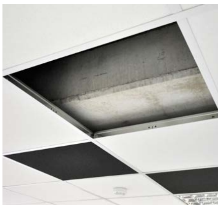
2 - Maglia 60 x 60 dopo la rimozione di un pannello in cartongesso
