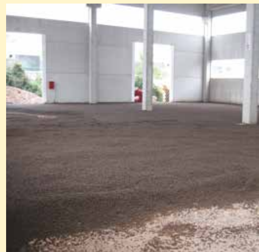
Vespaio isolato in Leca TermoPiù cementato ad alta resistenza meccanica.
