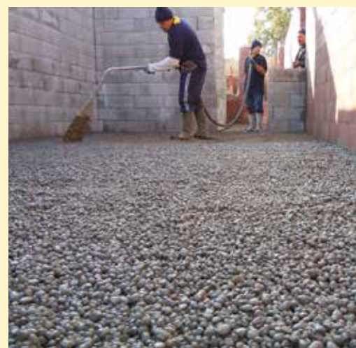
Vespaio isolato in Leca TermoPiù imboiaccato.
