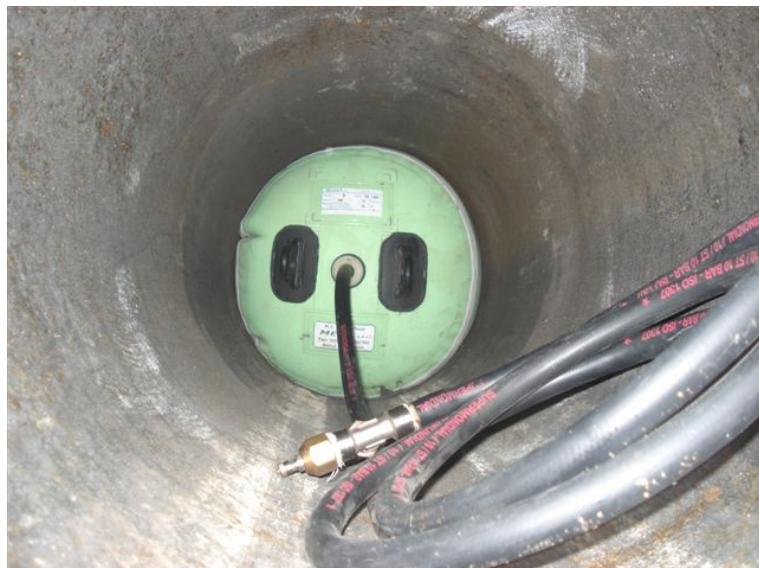
Dopo il corretto posizionamento dello stesso nella tubazione con l'ausilio delle apposite maniglie, il tappo è gonfiabile con aria/azoto attraverso un tubetto flessibile dotato di valvolina e di valvola di sfato di sicurezza.
