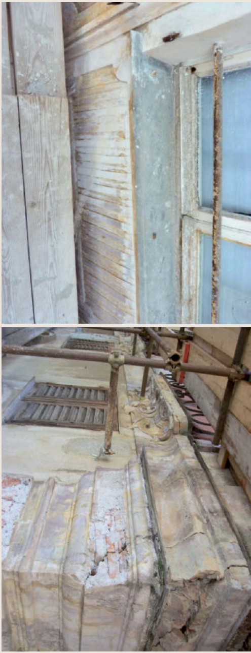
I pannelli sottofinestra all'ultimo piano sono caratterizzati da una rigatura verticale. Questi differiscono da pannello a pannello, segno evidente della loro realizzazione a mano. Nei casi in cui il fenomeno di distacchi era piuttosto esteso si è deciso per la rimozione delle parti non adese al supporto e al lavaggio accurato del settore mediante acqua ruscellante.
