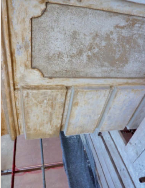
Nel caso dei bugnati d'angolo, la situazione si presentava maggiormente compromessa, soprattutto nella parte di levante: ciò era dovuto non soltanto a una perdita dal pluviale protrattasi nel tempo, ma anche a un gioco di venti e correnti che si vengono a creare nella zona tra la piazzetta e il vicolo. Si è quindi proceduto all'integrazione di alcune parti mancanti e al consolidamento delle parti in buono stato.
