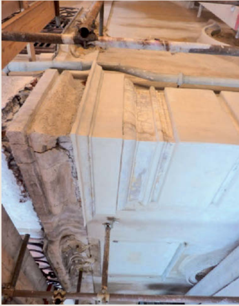
Nel caso dei bugnati d'angolo, la situazione si presentava maggiormente compromessa, soprattutto nella parte di levante: ciò era dovuto non soltanto a una perdita dal pluviale protrattasi nel tempo, ma anche a un gioco di venti e correnti che si vengono a creare nella zona tra la piazzetta e il vicolo. Si è quindi proceduto all'integrazione di alcune parti mancanti e al consolidamento delle parti in buono stato.
