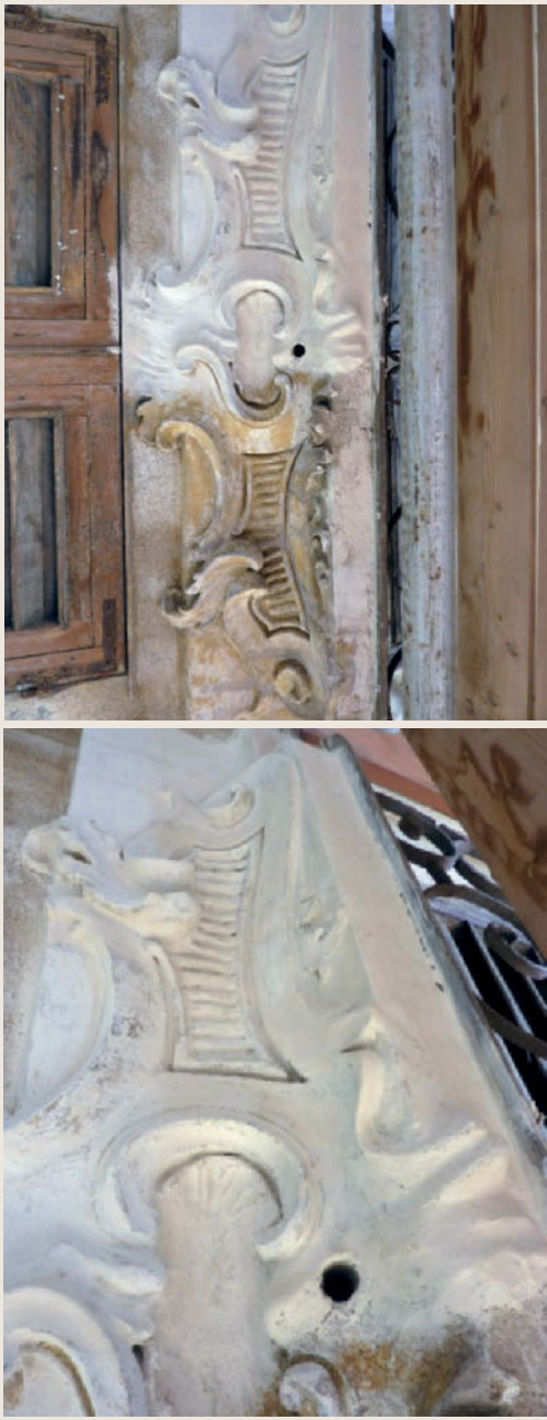
Dove le mancanze erano consistenti, invece, si è preventivamente provveduto alla realizzazione di una sesta dalle omologhe cornici per ricreare la continuità tematica. Poi, a seconda della grandezza della mancanza, si procedeva alla ricostruzione con inerti e malta o soltanto con lo strato di intonaco. A questo punto si veniva a riproporre un livello complanare tra parti originali e quelle ex novo.
