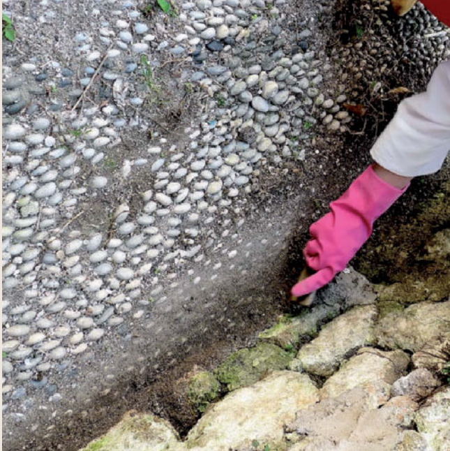
La pulitura è stata eseguita con pennelli a setole morbide; in questo caso sono stati rimossi anche i residui di terra tra un ciottolo e l'altro mettendo in vista il giunto di malta tra i ciottoli e per la disinfezione da vegetazione inferiore e superiore. A finire sono stati rimossi tutti i residui delle precedenti operazioni con un getto di acqua a media pressione.
