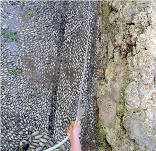
La pulitura è stata eseguita con pennelli a setole morbide; in questo caso sono stati rimossi anche i residui di terra tra un ciottolo e l'altro mettendo in vista il giunto di malta tra i ciottoli e per la disinfezione da vegetazione inferiore e superiore. A finire sono stati rimossi tutti i residui delle precedenti operazioni con un getto di acqua a media pressione.
