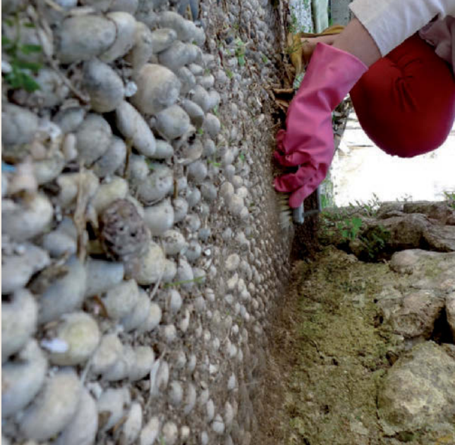
Una cauteia che è stata presa è stata quella di rimuovere con piccole pale e con operazioni manuali la parte di terreno. Il pericolo infatti per una parte di coclaki è la progressiva perdita dei ciottoli ai margini delle lacune. In questi punti infatti lo strato di malta entro il quale sono infissi i ciottoli risulta esposto agli agenti atmosferici e tende a disgregarsi.
