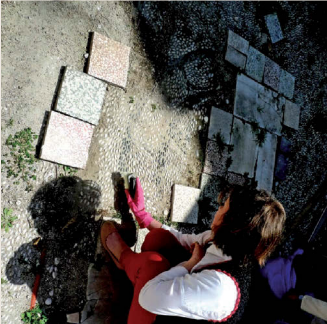
Una cauteia che è stata presa è stata quella di rimuovere con piccole pale e con operazioni manuali la parte di terreno. Il pericolo infatti per una parte di coclaki è la progressiva perdita dei ciottoli ai margini delle lacune. In questi punti infatti lo strato di malta entro il quale sono infissi i ciottoli risulta esposto agli agenti atmosferici e tende a disgregarsi.
