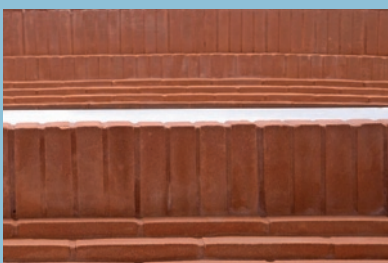
Vista dal basso del rivestimento della fascia marcapiano tra i due livelli superiori.
