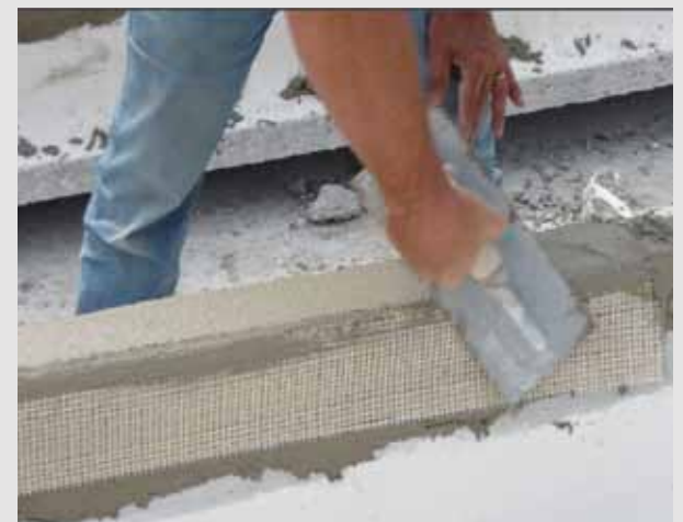
Fig. 2 applicazione della malta Concrete Rock W e del tessuto in acciaio STEEL NET 190 su supporto in cls.
