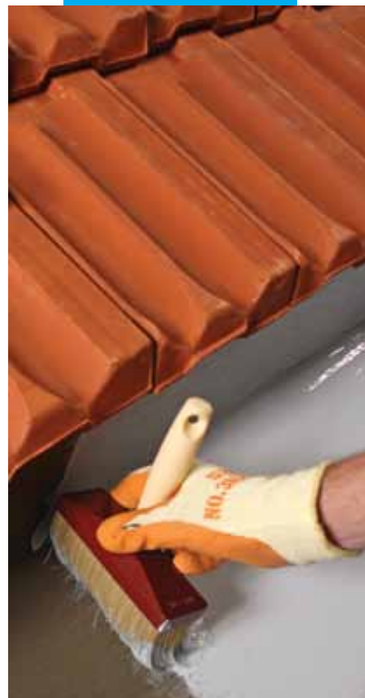
Particolare di gronda impermeabilizzata con Mapelastic Smart e rivestita con Elastocolor Waterproof
