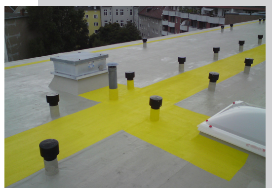
Risanamento di tetto piano con Triflex ProTect
