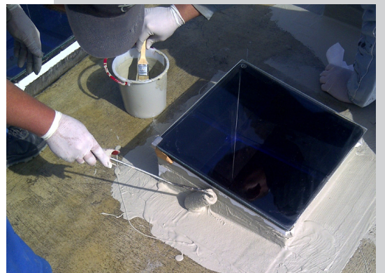
Impermeabilizzazione di dettaglio con Triflex ProDetail
