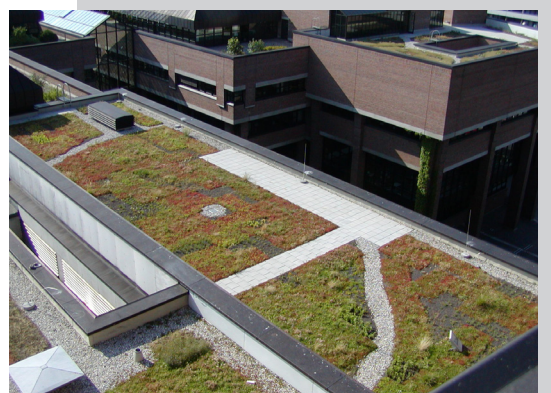
Impermeabilizzazione di tetto verde con Triflex ProTect
