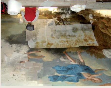
Zona interessata da infiltrazioni durante e dopo il restauro.
