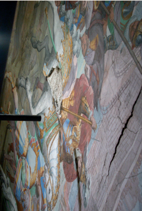
Rilievo delle giornate. Sono visibili le sovrapposizioni delle giornate, l'incisione diretta e indiretta (con cartone) e la quadratura di riferimento per riportare il disegno. Sulla volta i frammenti d'intonaco recuperabili dal crollo sono stati ricollocati mediante velinatura di sostegno e protezione della policromia con Paraloid denso in soluzione con etilacetato.
