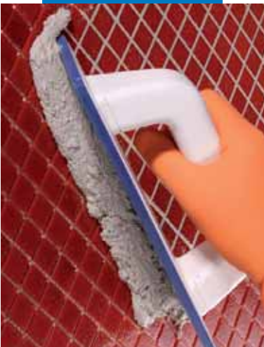
Applicazione di Kerapoxy Design
