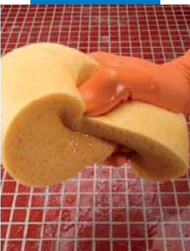
Bagnatura della superficie stuccata prima della pulizia
